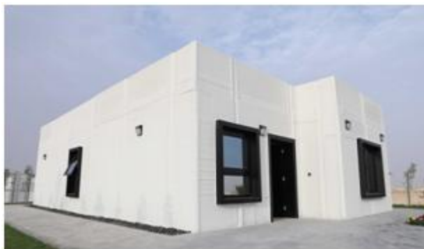
Рисунок 1 – Жилой дом, построенный в АОЭ по технологии 3D-печати
