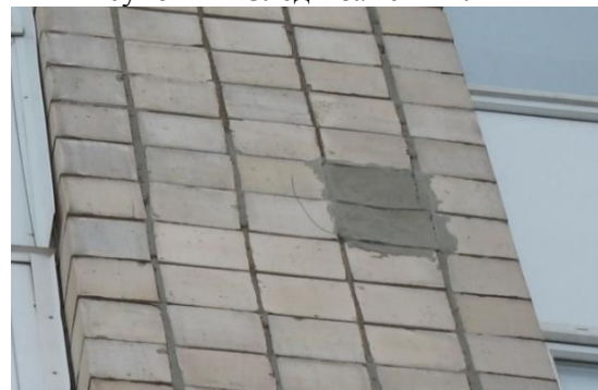
Рисунок 6 – Замена плитки раствором
