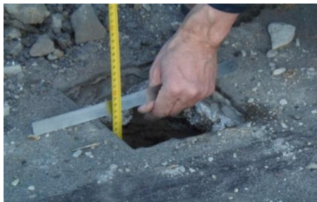
Рисунок 1 – Вскрытие: толщина ограждающих слоев покрытия составляет 570 мм
