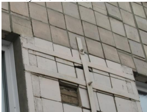
Рисунок 5 – Отсутствие плитки
