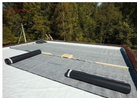
Рисунок 1 – Укладка геомембраны
