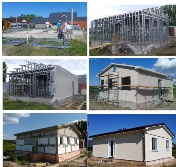
Рисунок 3 – Этапы строительства дома-лаборатории
