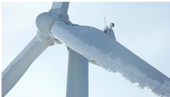
Рисунок 2 – ВЭУ с наледью на лопастях
