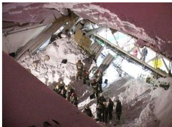
Рисунок 2 – Обрушения покрытия гипермаркета «Окей»
