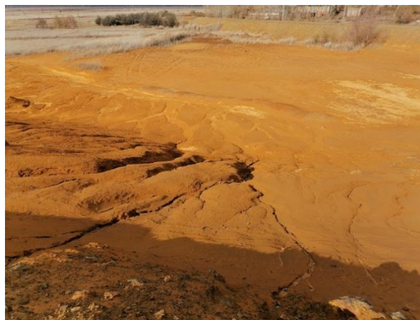
Рисунок 2 - Последствия размывания хвостохранилища
