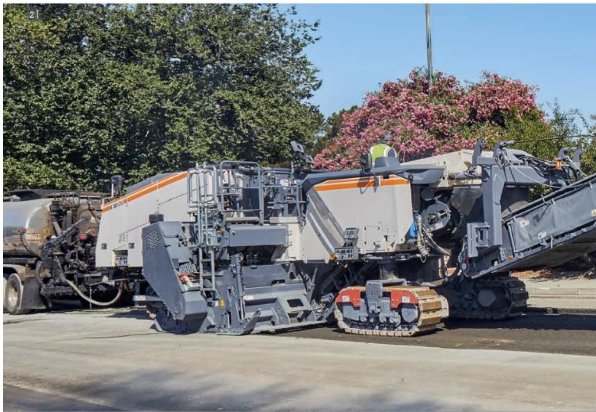
Рисунок 1- Технология проведения холодного ресайклинга, с использованием ресайклеров фирмы Wirtgen
