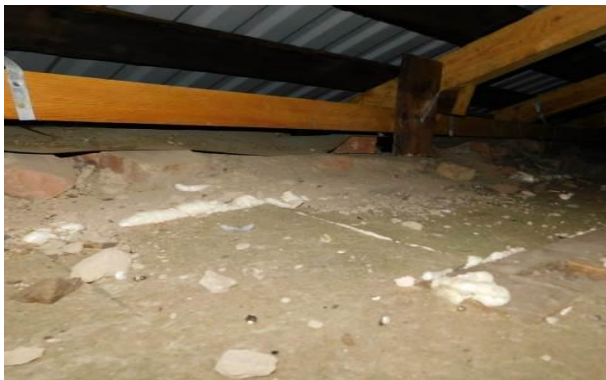
Рисунок 3 – Опираение мауэрлата на подкладки из кирпича
