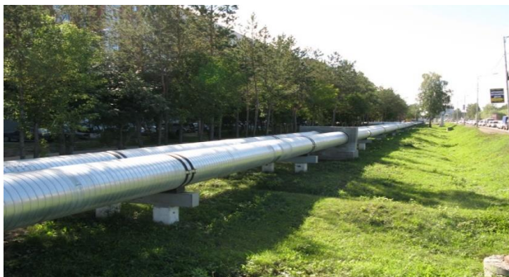
Рисунок 3 – Прокладка надземных газопроводов
