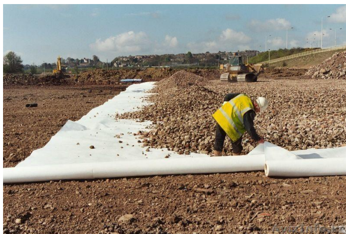
Рисунок 5- Укладка щебня на геотекстиль
