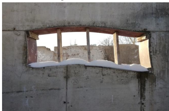
Рисунок 8 – Низкое качество выполнения строительно-монтажных работ
