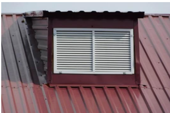
Рисунок 5 – Слуховое окно. Видна узкая угловая деталь, перекрывающая примыкание кровли к слуховому окну
