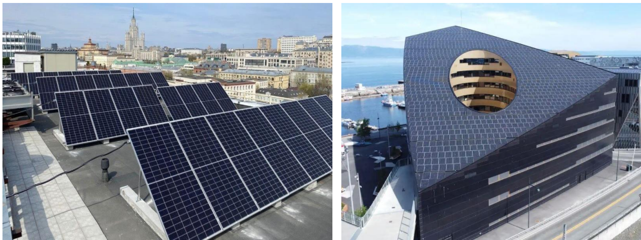
Рисунок 4 – Примеры фотоэлектрической системы на покрытии
