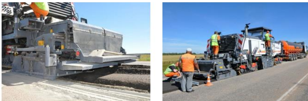
Рисунок 1 - Применение метода холодного ресайклинга для автомобильной дороги Павловск-Ребриха-Буканское
