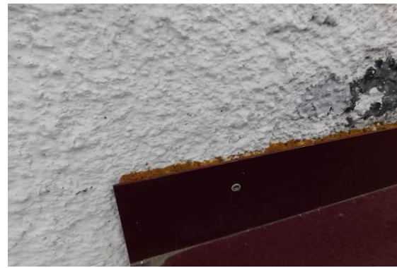
Рисунок 4 – Примыкание кровли пристройки к торцевой стене здания
