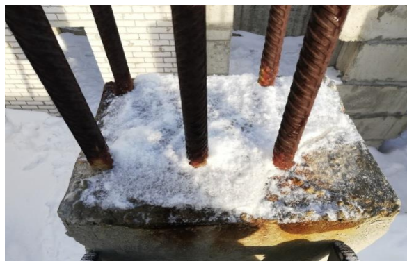
Рисунок 6 – Отклонения от проектного положения каркасов в сечении колонны
