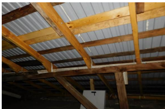
Рисунок 7 – Уплотнение стыков профлистов монтажной пеной
