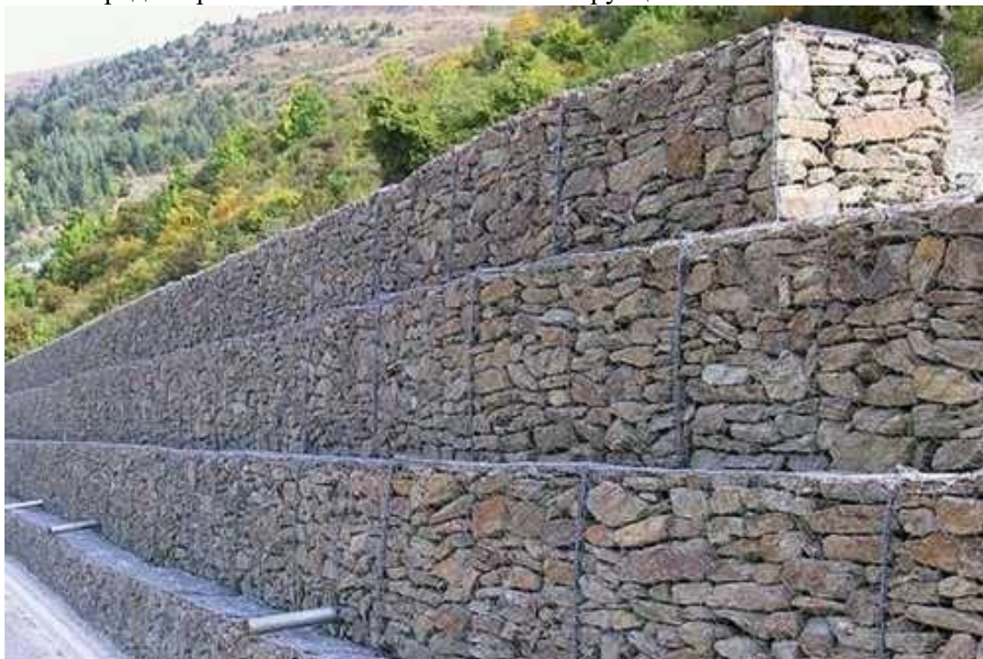
Рисунок 1 – Габионные конструкции (коробчатые)
