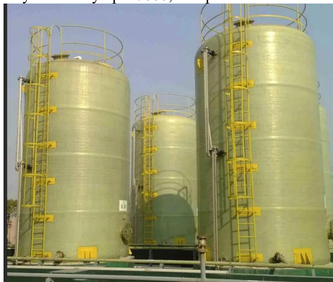
Рисунок 2 – Стекловолоконный бак GRPFRP для воды и масла
