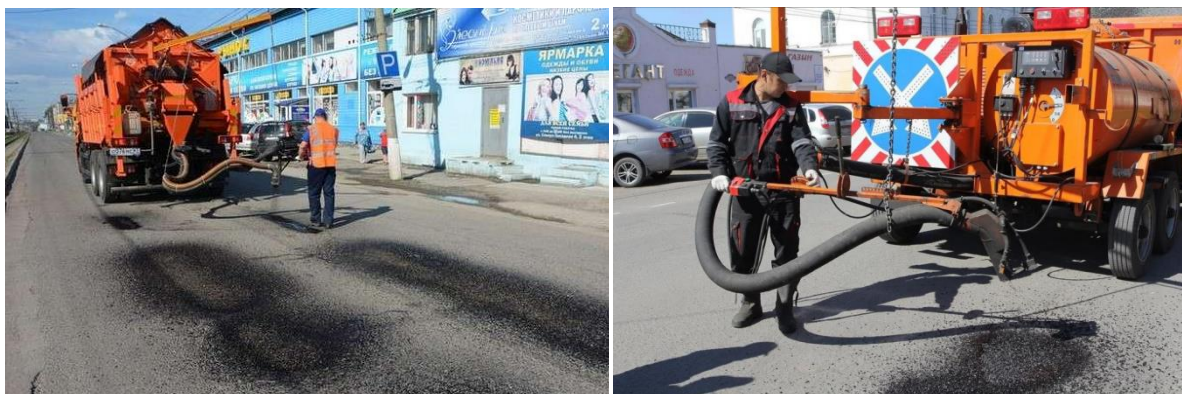
Рисунок 1 – Ремонт асфальтобетонных покрытий с использованием струйно-инъекционного способа
