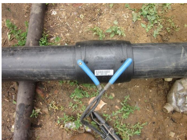
Рисунок 3 – Сварка ПЭ труб с помощью электромuffты
