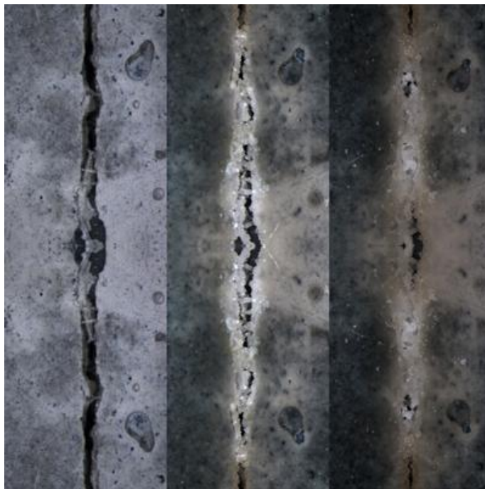
Рисунок 2 – Процесс восстановления трещины
