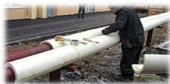
Рисунок 2 – Технология монтажа стандартной скорлупы из пенополиуретана (ППУ)
