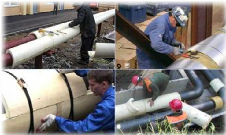
Рисунок 3 – Технология теплоизоляции труб скорлупами из пенополиуретана (ППУ)
