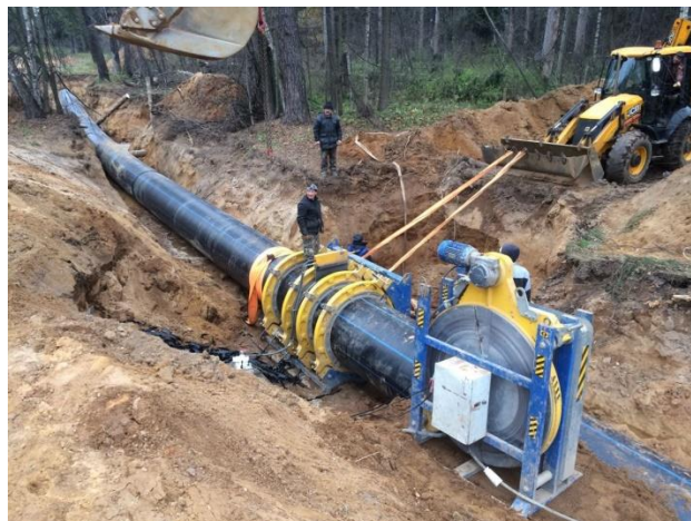
Рисунок 1 – Прокладка полиэтиленового газопровода
