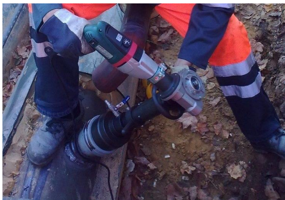
Рисунок 2 – Процесс холодной резки
