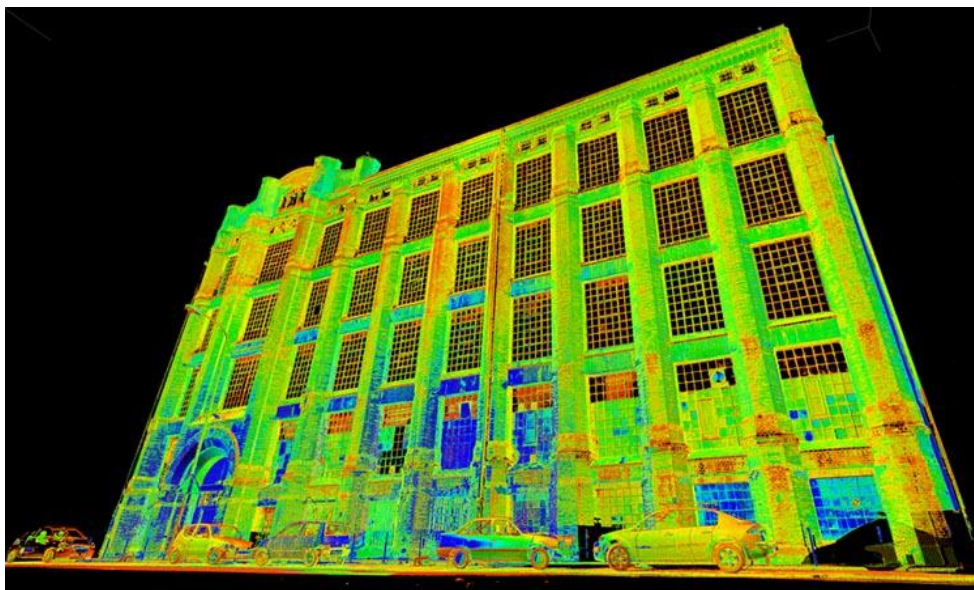
Рисунок 1 – Результат лазерного сканирования фасада здания
