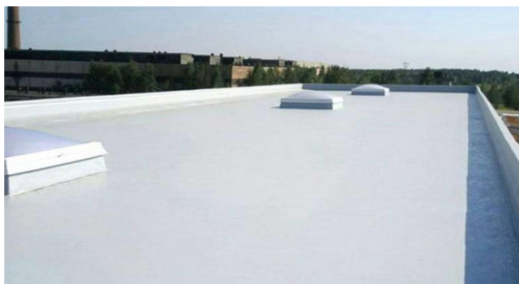
Рисунок 1 – Пример плоской кровли с применением полимерной мембраны
