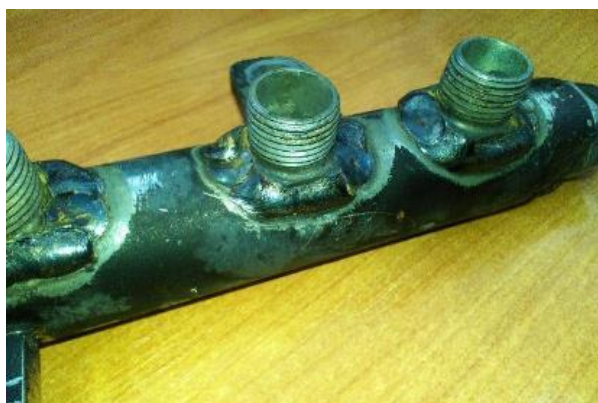
Рисунок 10 – Аккумулятор после ремонта (приварки бонков)
