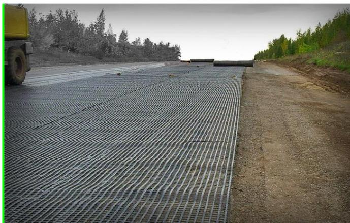
Рисунок 1- Геосинтетические материалы в дорожном строительстве
