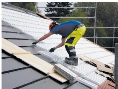
Рисунок 1- Технология укладки стеклянной черепицы при устройстве кровли
