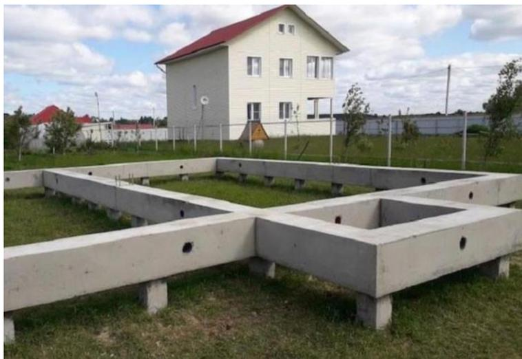
Рисунок 3 – фундамент с забивными сваями
