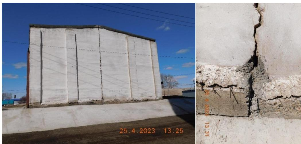
Рисунок 2 - Сквозная вертикальная трещина в наружной торцевой стене здания
