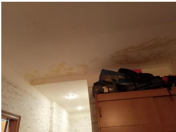
Рисунок 1 – Пятна и разводы желтого цвета на поверхности потолка и стен в квартире жилого дома по адресу: г. Барнаул, пр-т Ленина, д. 167-12
