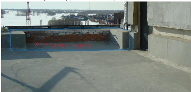
Рисунок 3 - Нештукатуренная поверхность кирпичной кладки над помещением холодной лоджии
