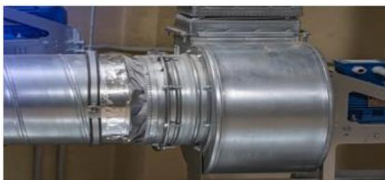
Рисунок 2 – Фланцевое соединение воздуховодов
