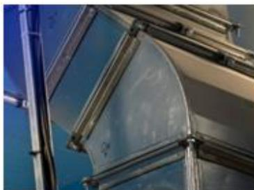
Рисунок 3 – Бандажное соединение воздуховодов
