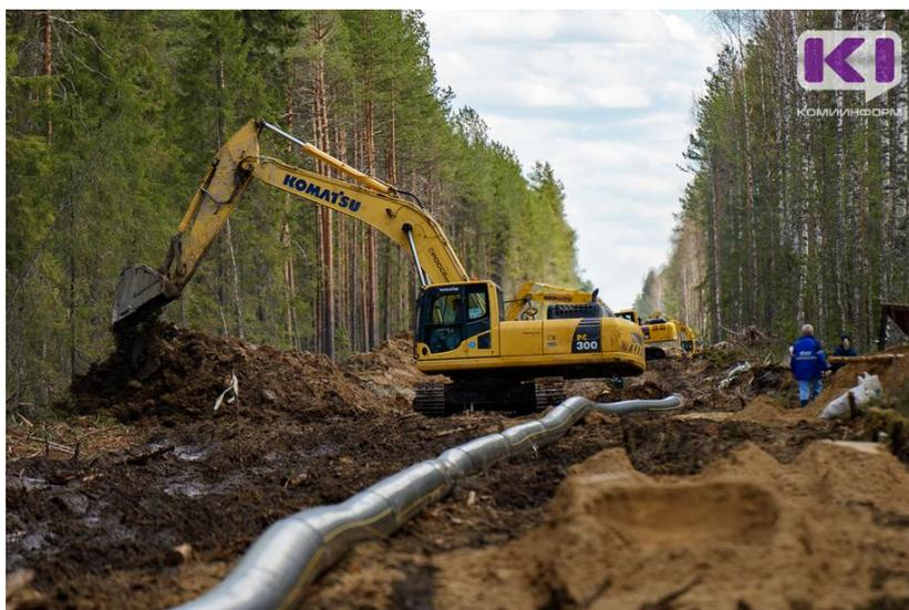
Рисунок 2 – Прокладка газопровода
