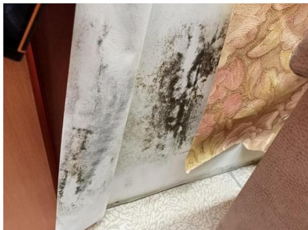
Рисунок 2 - Коробление и вздутие полотнищ обоев, плесень на обратной стороне полотнищ обоев и поверхности стен в квартире жилого дома по адресу: г. Барнаул, пр-т Красноармейский, 54-2
