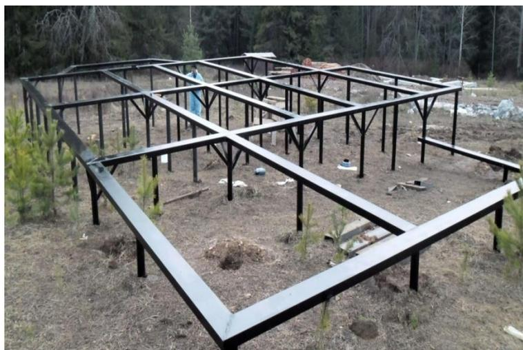
Рисунок 2 – фундамент с винтовыми сваями
