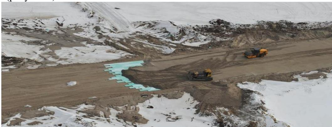
Рисунок 2 - Строительство федеральной трассы Салехард-Надым с использованием теплоизоляционных плит марки «Экстрол 45»
