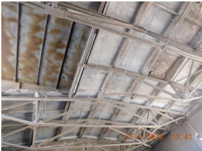
Рисунок 3 - Частичный демонтаж металлической фермы покрытия
