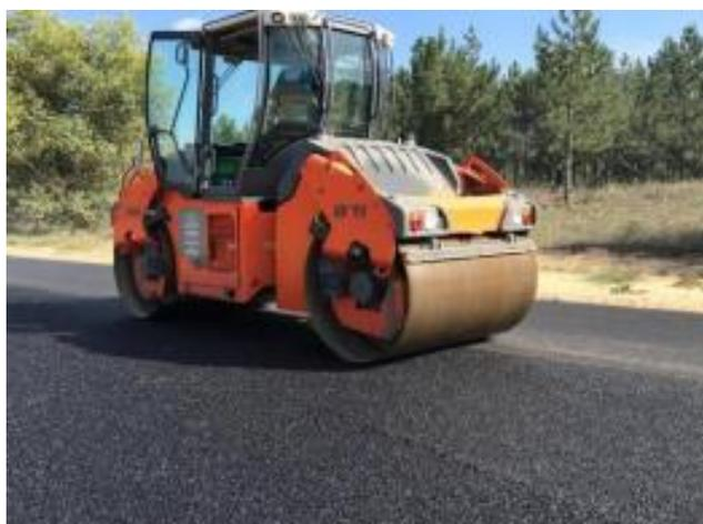
Рисунок 3 - Виброуплотнение
