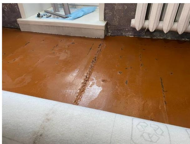
Рисунок 3 – Разбухание и коробление покрытия пола из ДВП в квартире жилого дома по адресу: г. Барнаул, ул. Папанинцев, 205-33.
