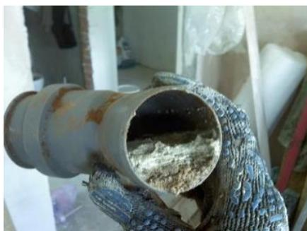
Рисунок 2 – Накопление отложений в трубопроводе
