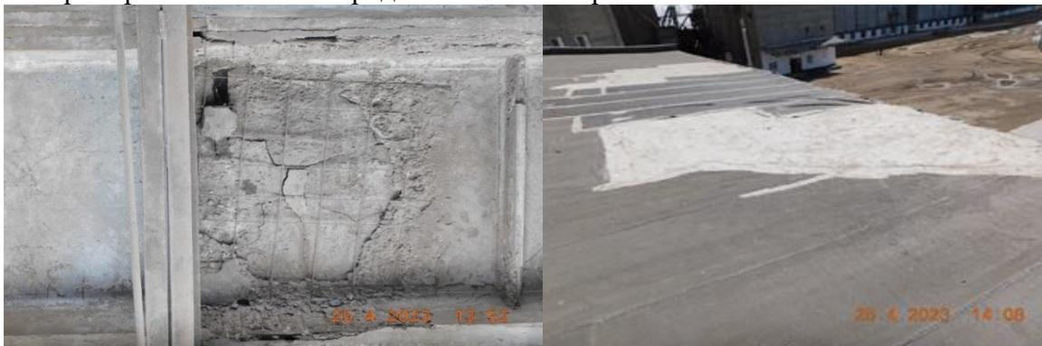
Рисунок 4 - Разрушение плиты покрытия, оголение и коррозия арматуры вследствие неисправности кровли
