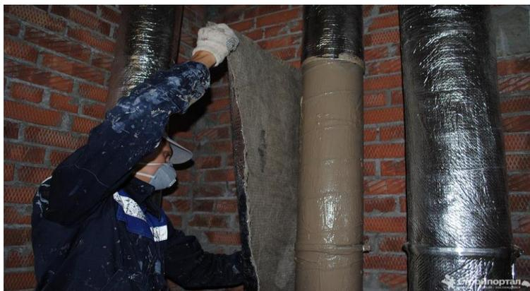
Рисунок 3 – Нанесение комплексной огнезащиты на подготовленный воздуховод
