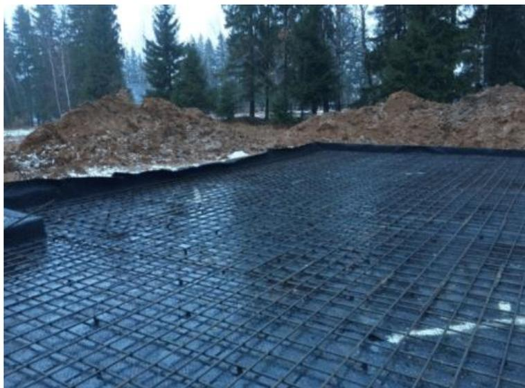
Рисунок 1 – плитный фундамент
