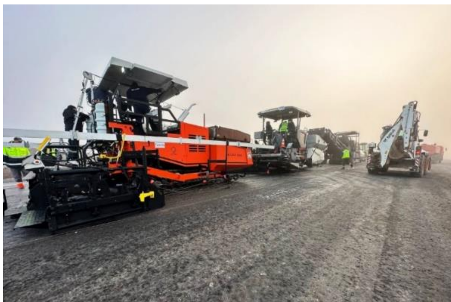
Рисунок 1 – Укладка асфальтобетонной смеси асфальтоукладчиками ДЕСНА 1800 и Дунарас
