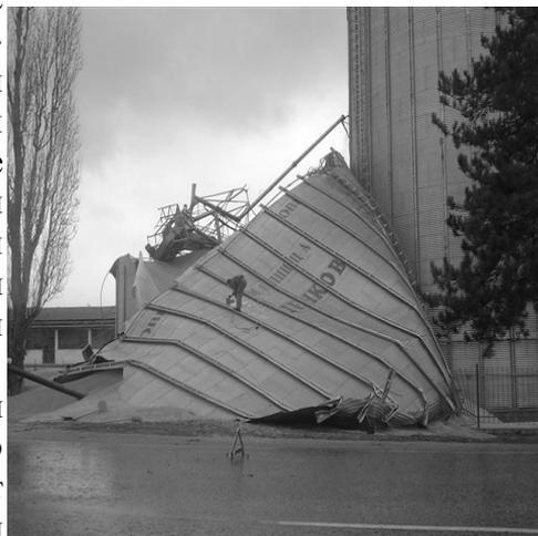
финансовым потерям для предприятий. Так современные металлические силоса для хранения зерна и зернопродуктов, с расчетным периодом эксплуатации до пятидесяти лет, при неграмотной эксплуатации выходят из строя через 5-7 лет [4]. А объем капиталовложений на восстановление аварийных емкостей может достигать до 50 % затрат от их первоначальной стоимости.
