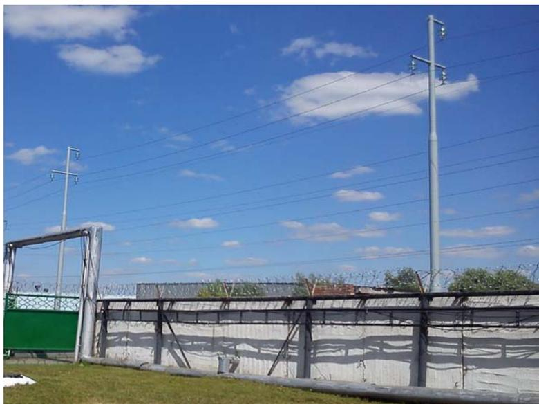
Рисунок 3 - Опоры ПК10-1 в исполнении с подвесной изоляцией
