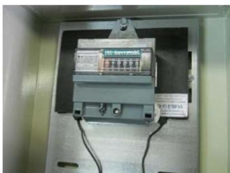
Рисунок 4 – Электронный счетчик с обогревателем МКЭ-1/1
