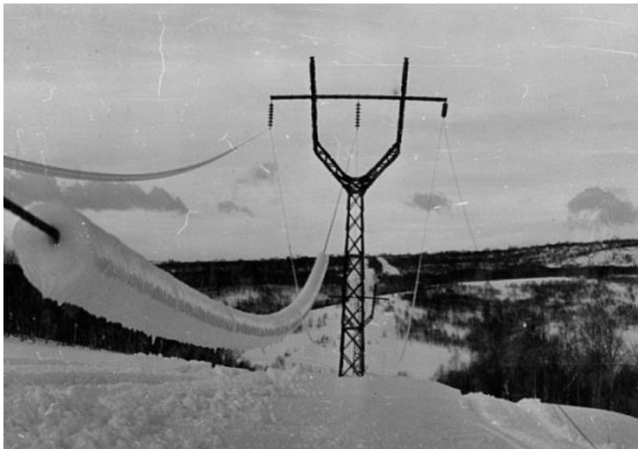
Рисунок 2 – Гололедное образование на проводах
