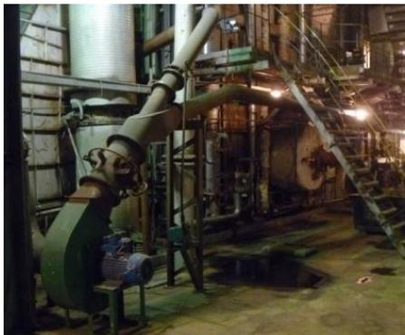
Рисунок 12 – Фото оборудования системы муфельной подсветки котла БКЗ-75-39ФБ
