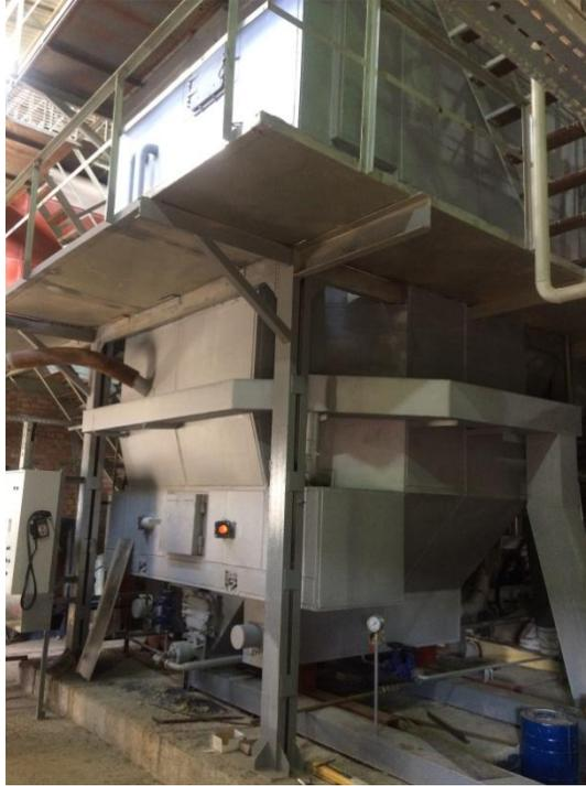
Рисунок 2 – Котлы KE-10-1,4 реконструированные с установкой вихревой топки «Торнадо»
