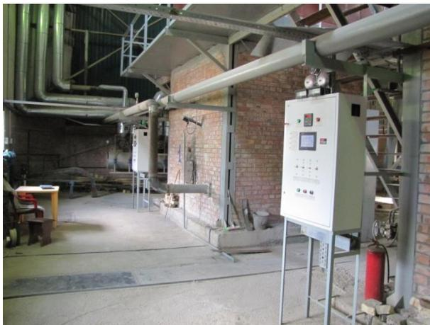
Рисунок 1 – Котлы КЕ-10-1,4 с кирпичными циклонным предтопками
