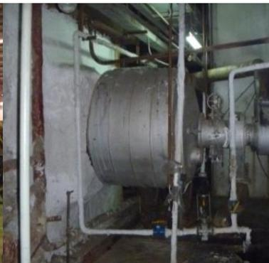
Рисунок 13 – Фото установки муфельной горелки на боковой стене топки котла БКЗ-420-140
