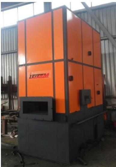
Рисунок 11 – Водогрейный котел КВМ-2,0ДВО установленный в республике Беларусь
