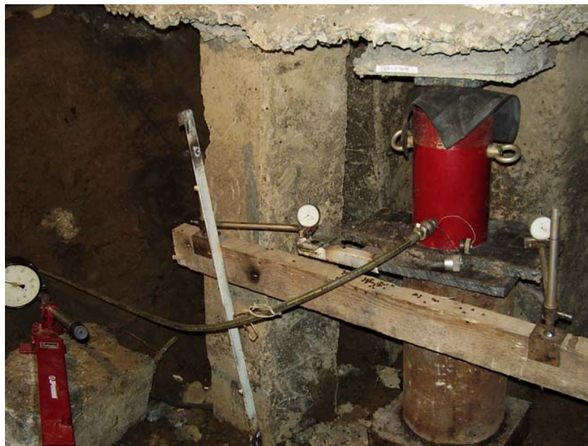
Рис. 2. Общий вид опытной сваи при испытании вдавливающей нагрузкой
