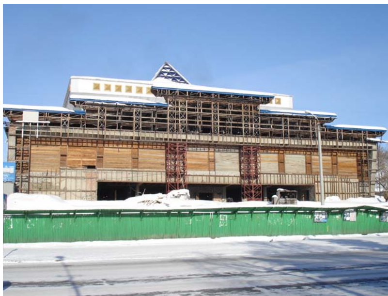
Рис. 1. Общий вид национального театра драмы в г. Горно-Алтайске во время реконструкции
