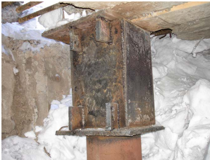
Рис. 3. Общий вид опытной сваи после проведения испытаний вдавливающей нагрузкой
