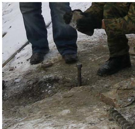
Рис. 3. Установка температурных труб на автодороге «Алтай-Кузбасс»
