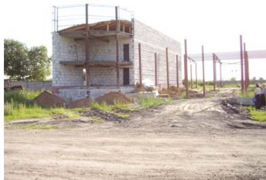
Рис. 1. Общий вид здания
