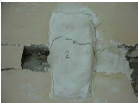
Рис. 8. Раскрытие маяка в подвальной части здания (первый этап наблюдений)
