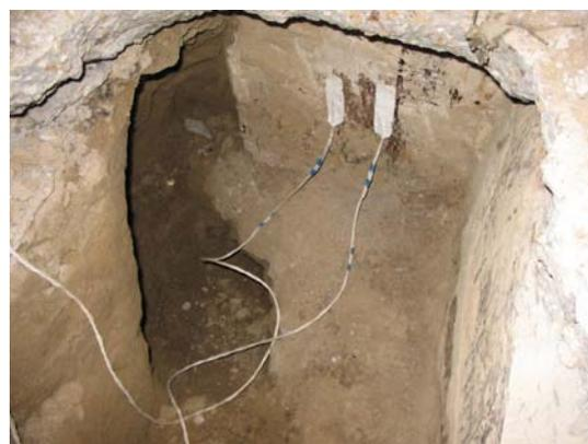
Рис. 10. Общий вид шурфа №3 с установленными на ростверк свайного фундамента тензометрическими датчиками
