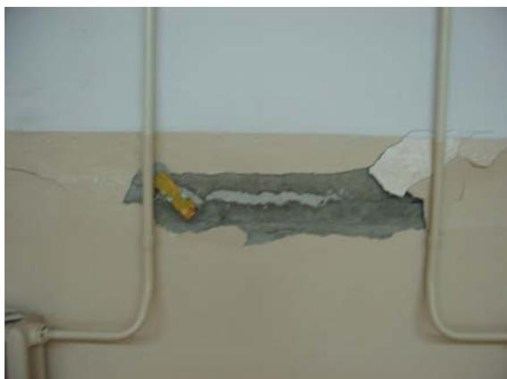
Рис. 7. Установка маяков на трещинах стена подвала
