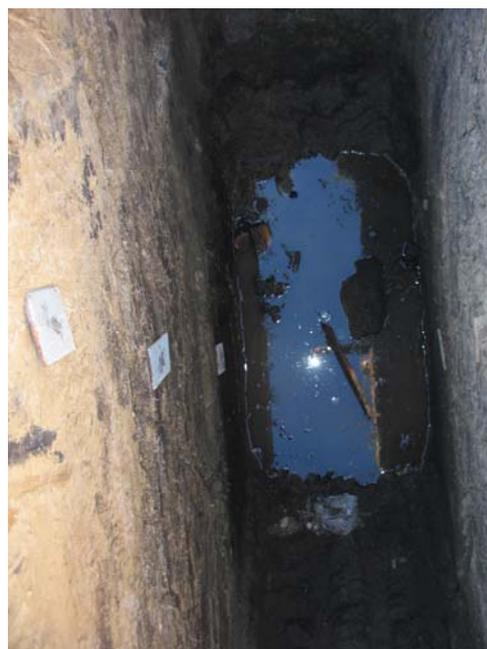
Рис. 9. Шурф №2 с установкой вертикальных металлических марок для наблюдения за деформациями основания
