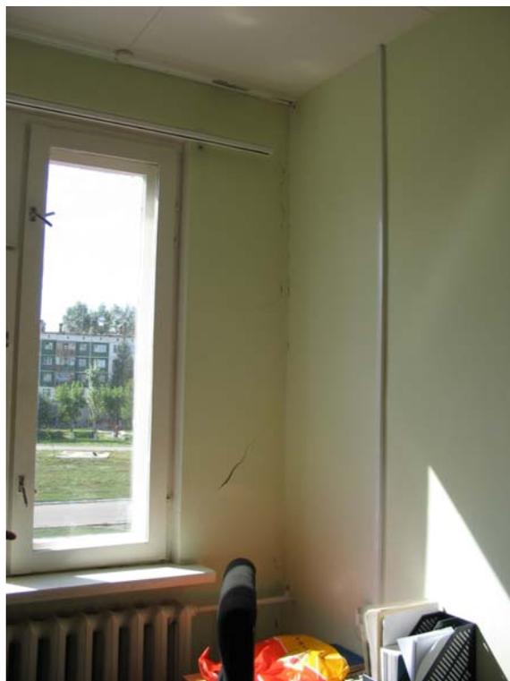
Рис. 6. Наклонная трещина в наружной стене
