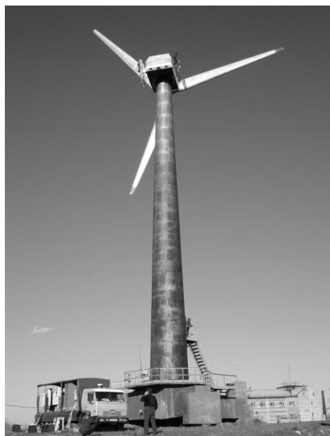
Рисунок 4 – Полевые испытания многофункционального энергетического комплекса на базе ветроэлектростанции «Заполярная» (г. Воркута) и всережимного двигатель-генератора
