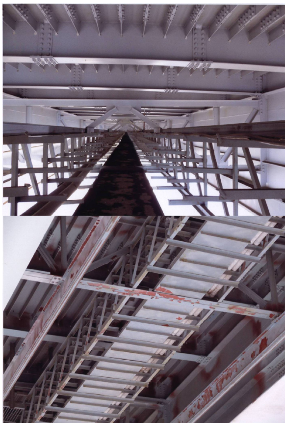
Рисунок 3 – Поперечные балки пролётного строения Обского моста
