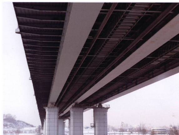
Рисунок 2 – Главные балки пролётного строения Обского моста
