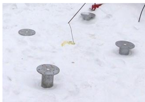
Рисунок 4 – Винтовые сваи «BAU» на экспериментальной площадке
