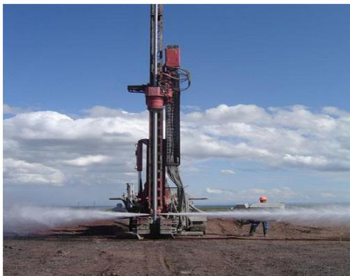
Рисунок 9 - Высокоточная струя цементного раствора
