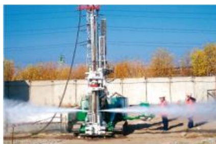
Рисунок 1 – Демонстрация кинетической энергии водоцементной струи инъекционной струйной установки
