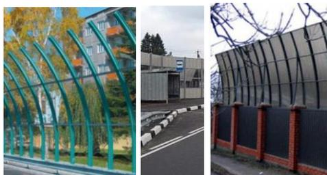
Рисунок 1 – Примеры устройства шумозащитных экранов
