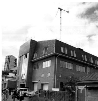
Рисунок 3 – Энергоавтономное здание на ул. Садогородская, 14 в г. Барнауле
